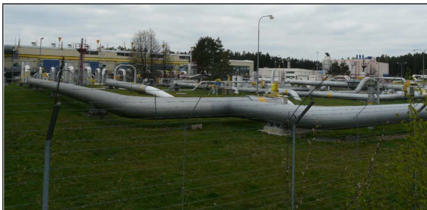
Obrázek 5: Kompresní stanice Kralice nad Oslavou
