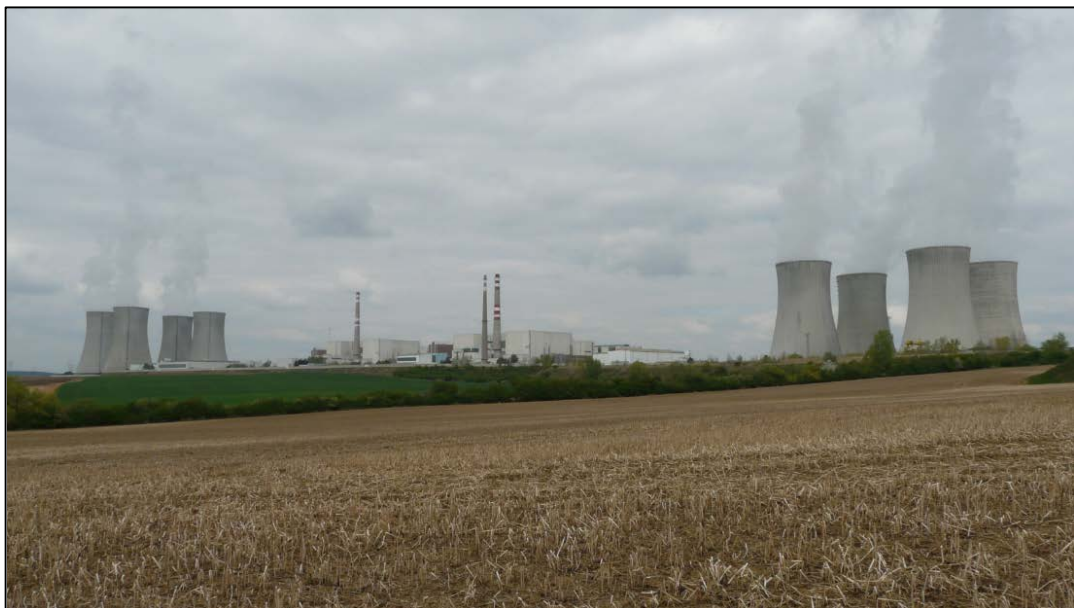
Obrázek 2: Jaderná elektrárna Dukovany [J. Doležalová, duben 2014]
