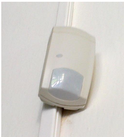
Obrázek 2 - Pohybové čidlo [Zdroj: vlastní]
