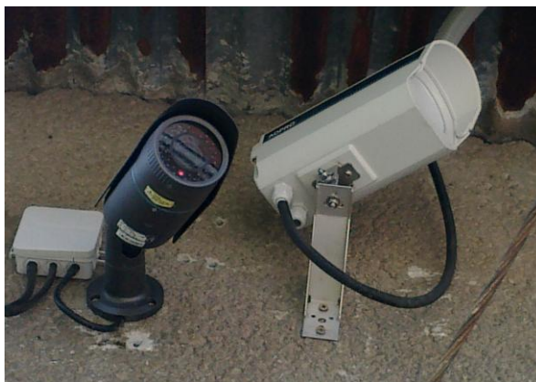
Obrázek 6 - Kamera a prostorové čidlo [Zdroj: vlastní]
