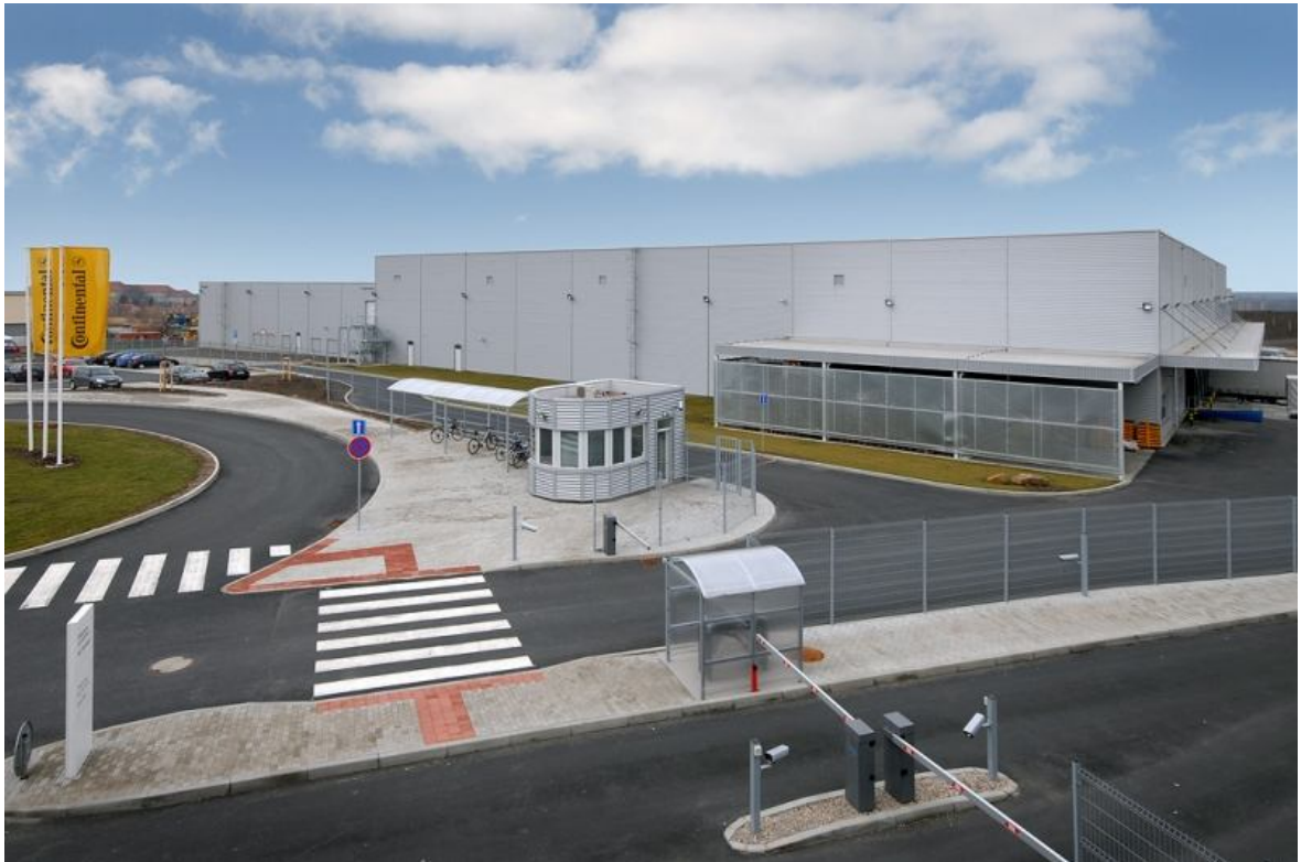
Obr. 18 Kontrola vjezdu do objektu 44
