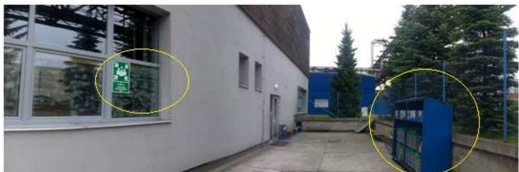
Obr. 21: Okolí kolem skladiště propan-butanu[zdroj: autor]
