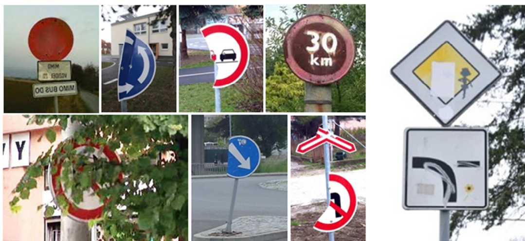
Obr. 16: Deformace dopravních značek
