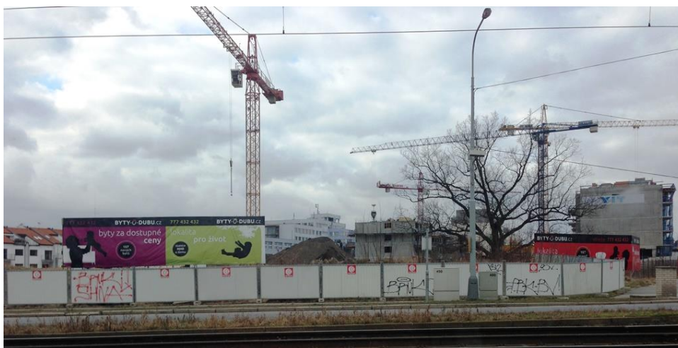
Obr. 22 Označení staveniště Byty U Dubu
