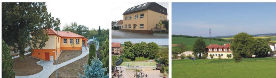
Obr. 22: Školní budovy: mateřská škola, základní škola, tělocvična
