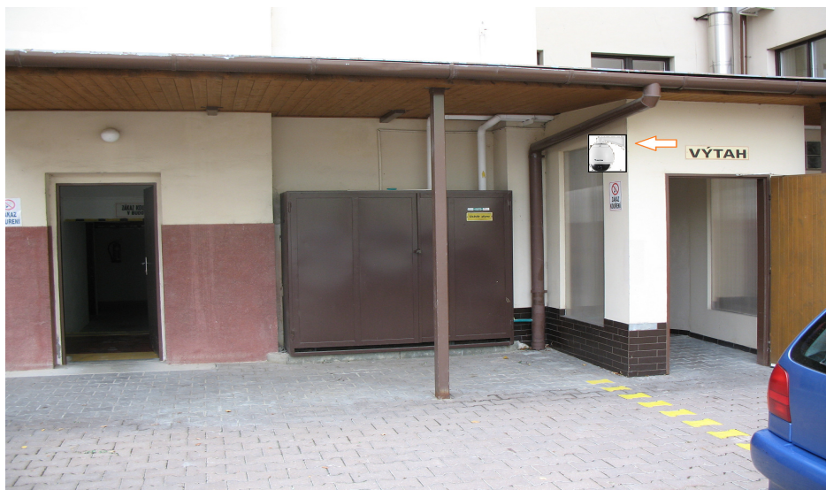
Obrázek 22. Pohled ze společného nádvoří na vstupní dveře do prostorů, kde je umístěna zabezpečená oblast
