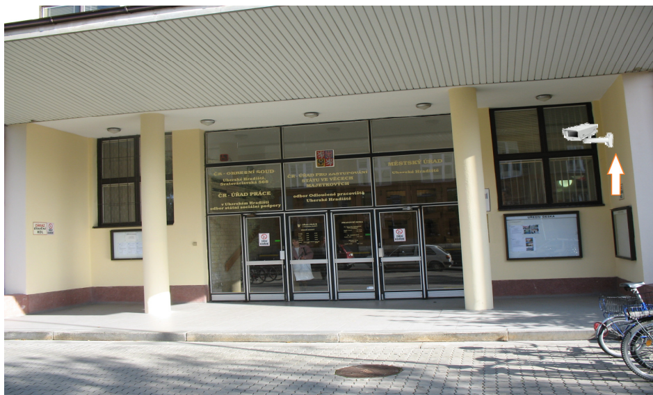
Obrázek 20. Pohled na společný vstup do areálu SAB
