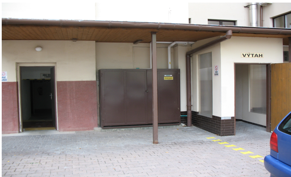
Obrázek 16. Pohled ze společného nádvoří na vstupní dveře do prostorů, kde je umístěna zabezpečená oblast
