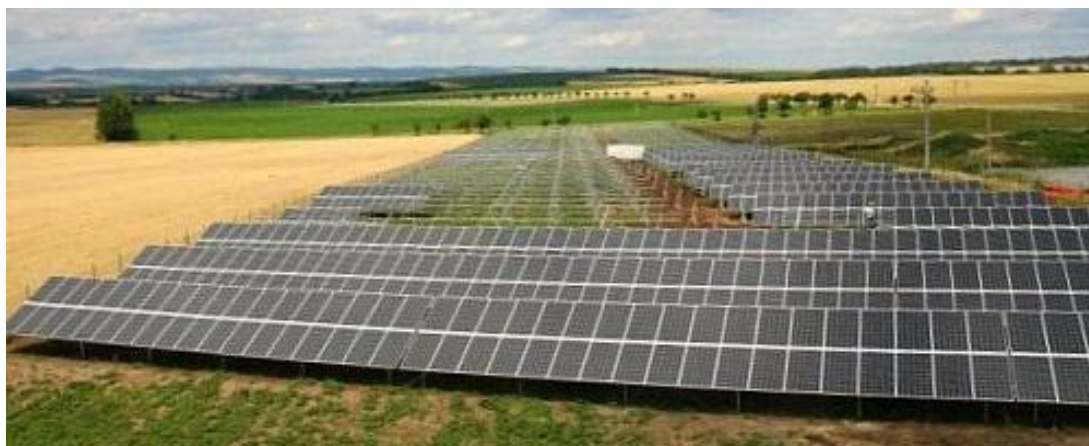
Obr. 52 Výstavba fotovoltaické elektrárny [31]
