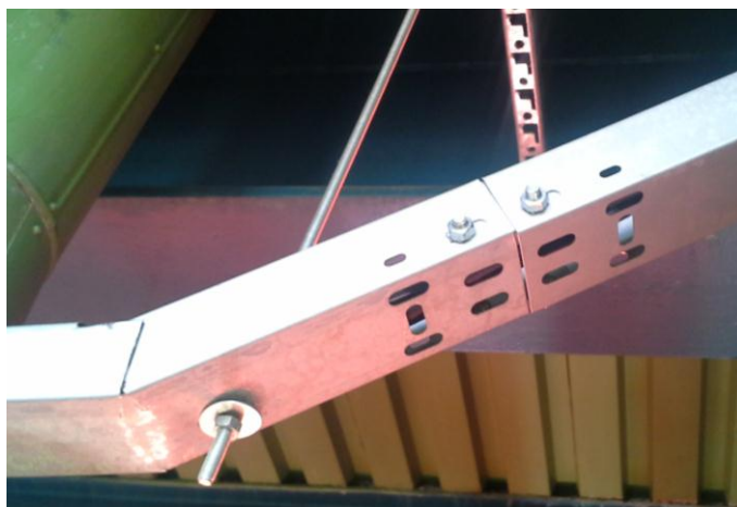
Obr. 3. Kabelový žlab.
