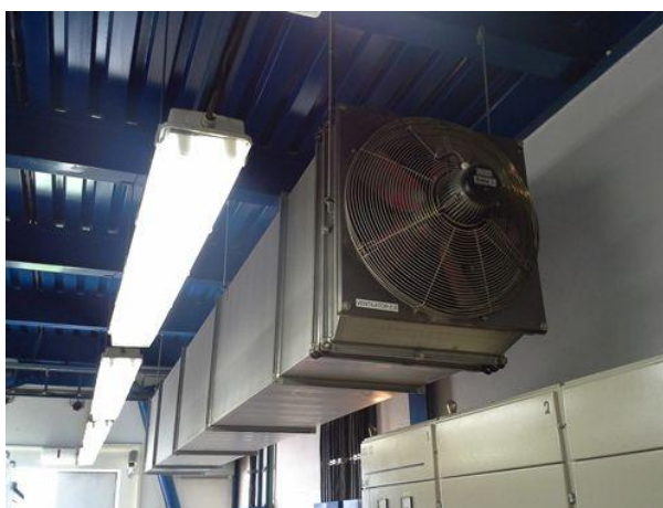
Obr. 33. Odsavač tepla a kouře.
