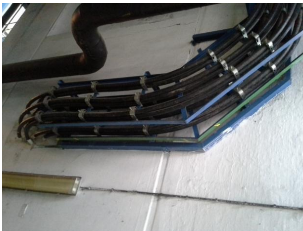
Obr. 9. Správné uložení kabelového vedení.
