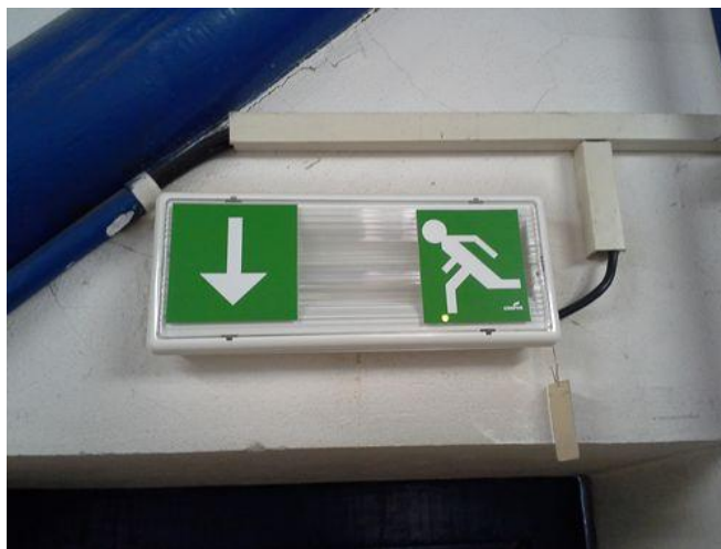
Obr. 39. Vzorové nouzové osvětlení nade dveřmi.
