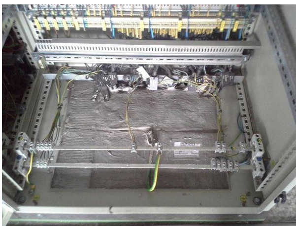
Obr. 25. Správně provedená ucpávka na dně rozváděče.
