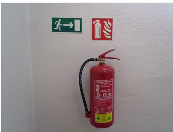
Obr. 38. Správné umístění hasicího přístroje.
