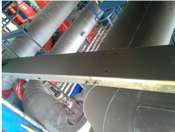
Obr. 12. Správné provedení kabelového žlabu.
