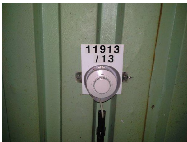
Obr. 16. Tepelný hlásič požáru.
