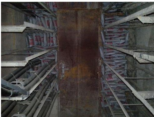
Obr. 18. Hlavní požární přepážka.
