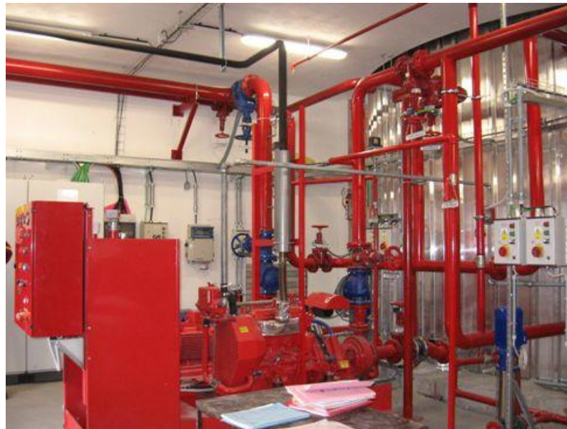
Obr. 4 - strojovna SSHZ
