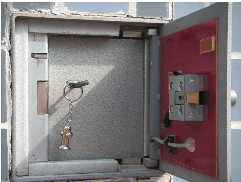
Obr. 6 - klíčový trezor požární ochrany (KTPO)
