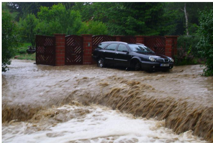
Obrázek 12. Propusti Černého potoka [Zdroj: vlastní]
