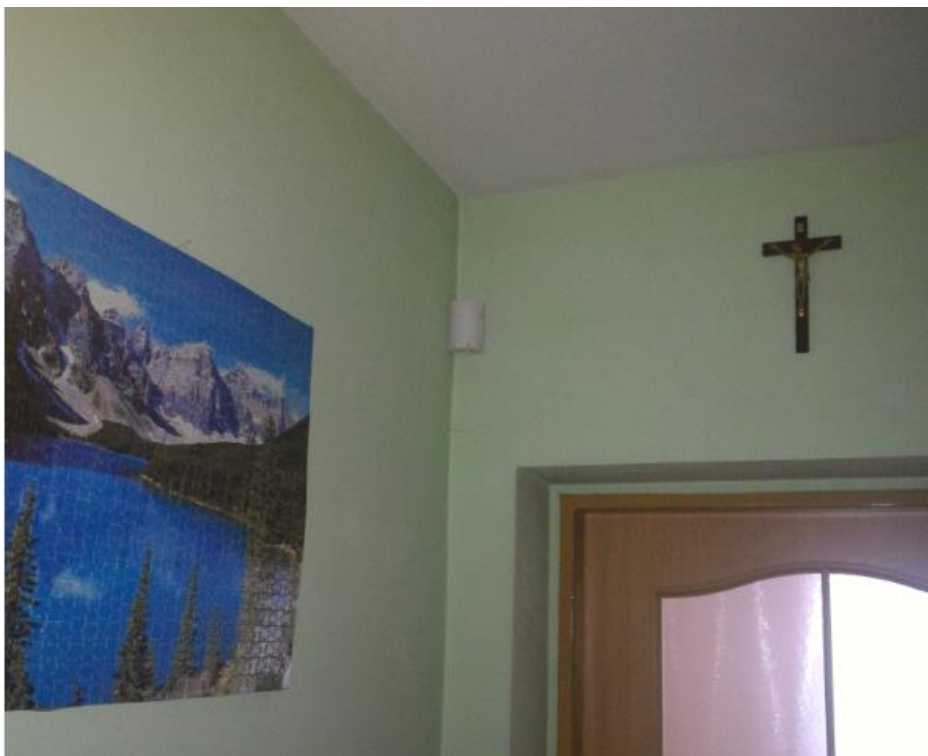
Obr. 10 PIR detektor na chodb
