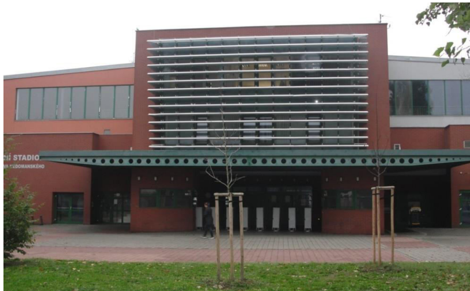
Obr. 6. Čelní pohled na zimní stadion [33]
