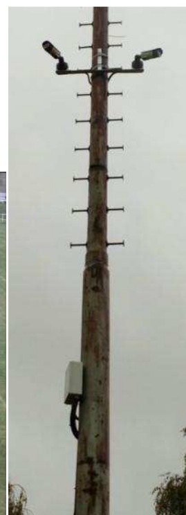
Obr. 28 Kamera na štadióne namierená na vchod a umiestnenie kamier [zdroj autor]
