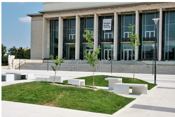
Obr. 32. Vstupní průčelí Janáčkovy divadla
