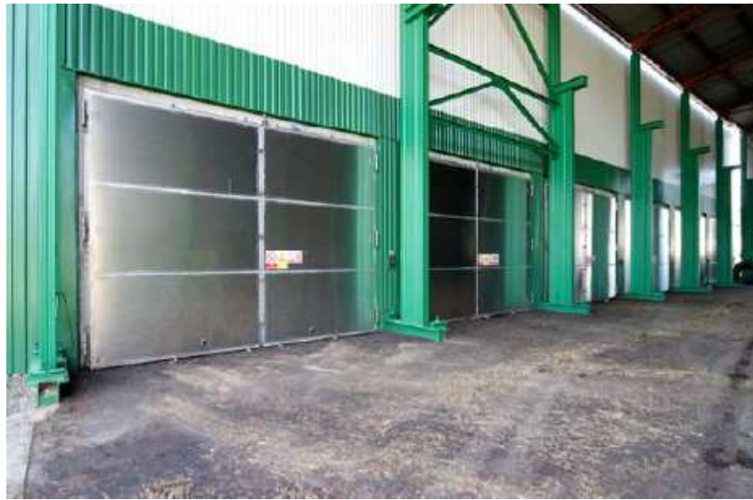
Obrázek 6 Bioplynová stanice v Šumperku – vrata fermentorů[18]
