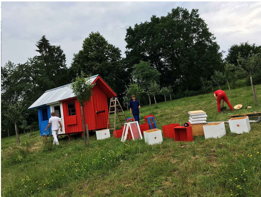
Obr. 33. Vojtěch Valda – výstavba modulu
