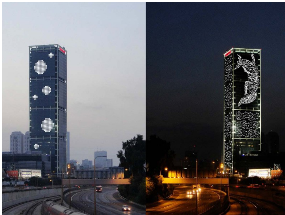
Obr. 58. Mrakodrap využívající technologii OLED pro zastínění i osvětlení
