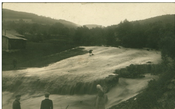
Obr. 2. Rozvodněný Kudlovský potok r.1926
