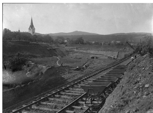
Obr. 3. Výstavba Kudlovské přehrady
