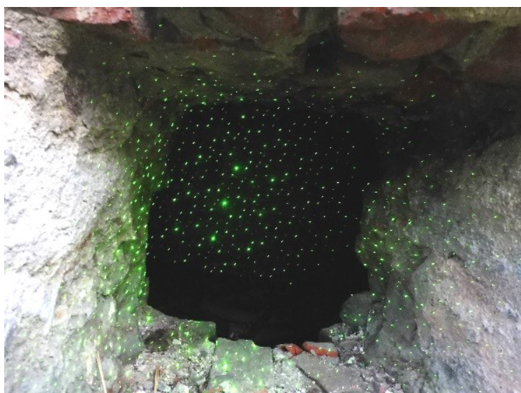
Obr. 69: Osvětlení kouřovodu
