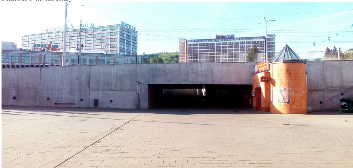
Pohled na jižní vstup
