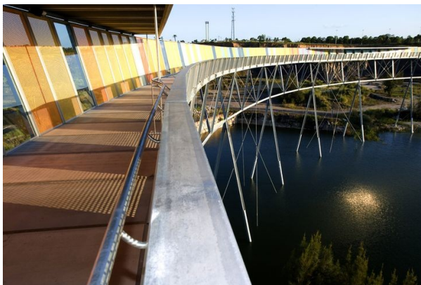
Obr.29: Lávka Brick Pit – konstrukce
