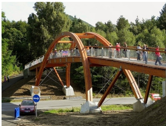
Obr.24: Cykloturistická lávka u Nového Boru
