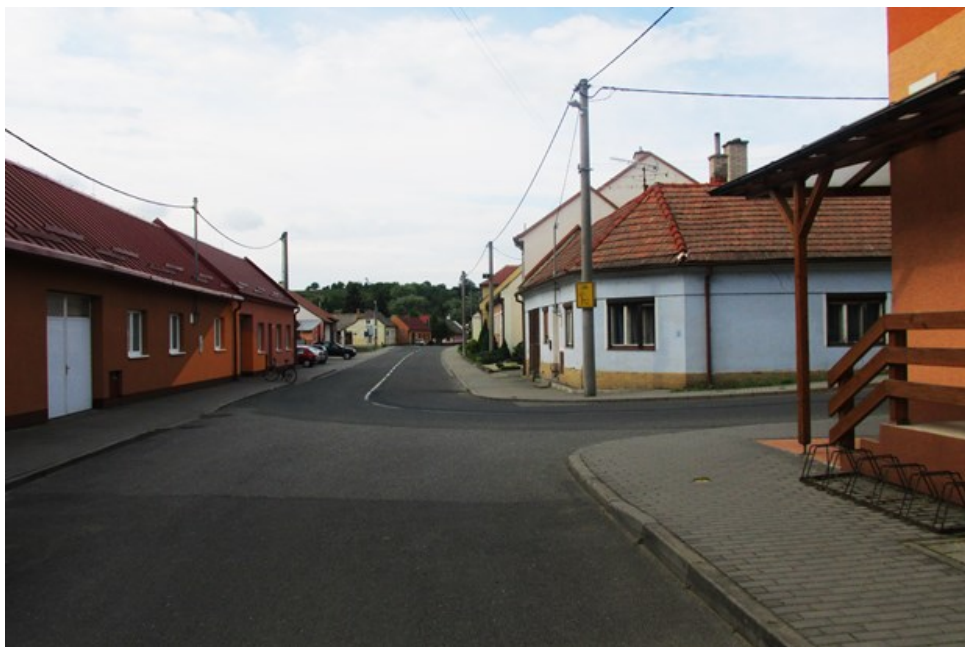
Obr. 9 Nepřehledná křižovatka na silnici třídy III/4225 [vlastní]
