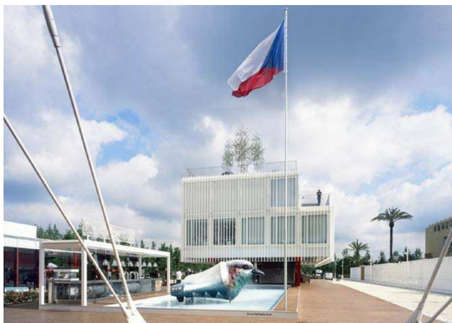
Obr. 17 – Modulová stavba KOMA
