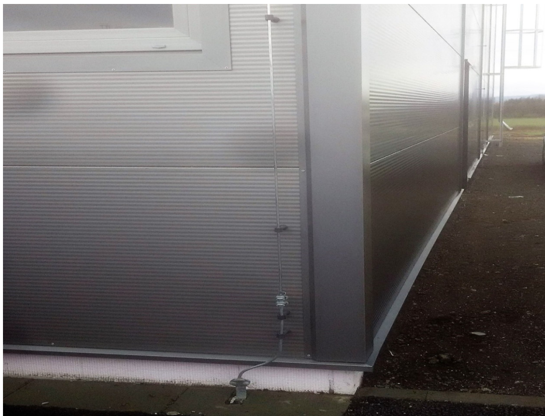
Obr. 27 Detail připojení uzemnění [Vlastní]
