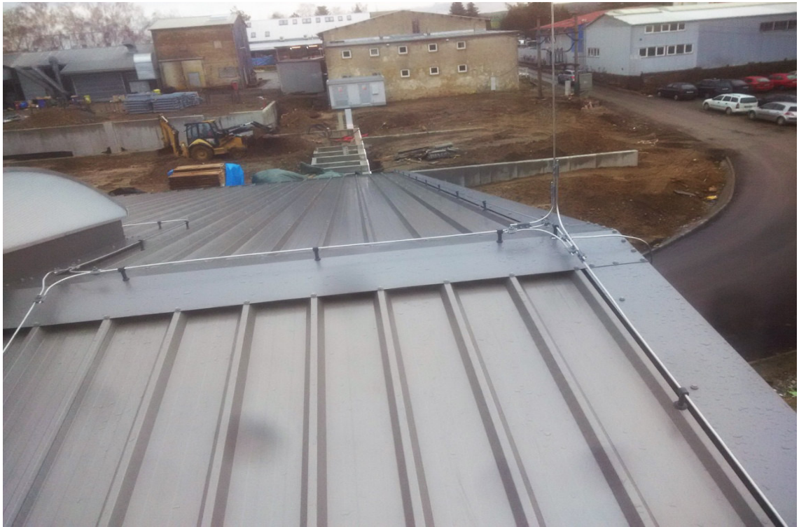
Obr. 22 Detail svodů [Vlastní]
