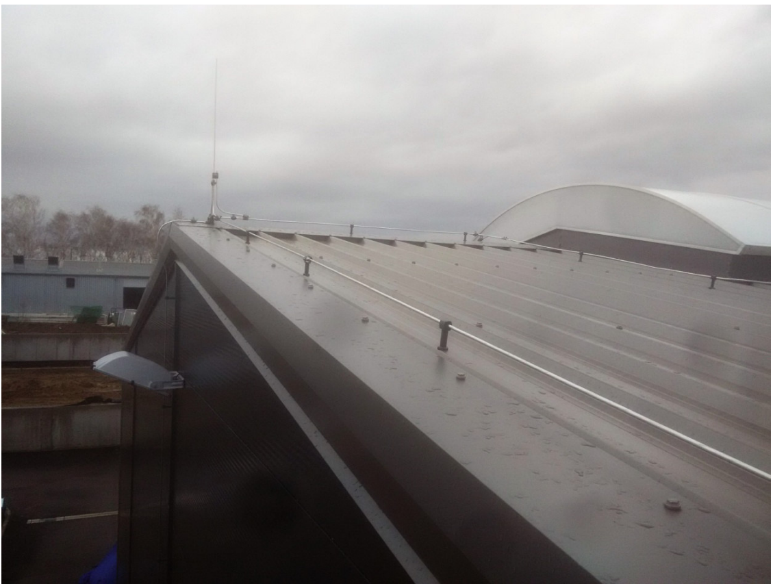
Obr. 25 Detail svodů [Vlastní]
