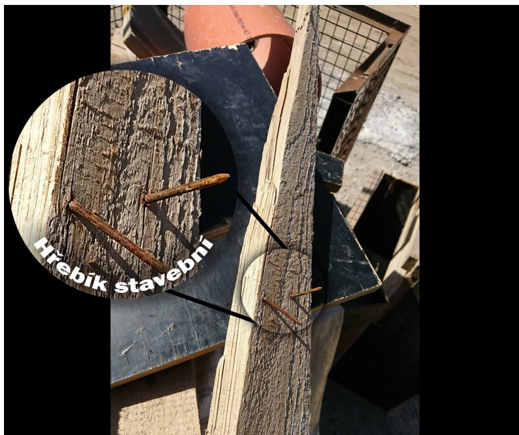
Obr. 9 – Hřebíky v řezu [8]
