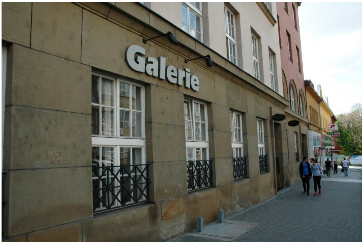
Obr. 36 - Galerie pod Radnicí, Prodejní galerie výtvarného umění
