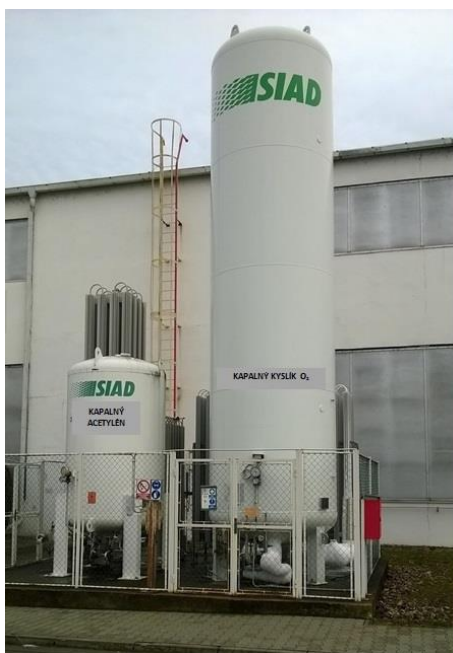
Obr. 4 Zásobníky s nebezpečnými látkami
