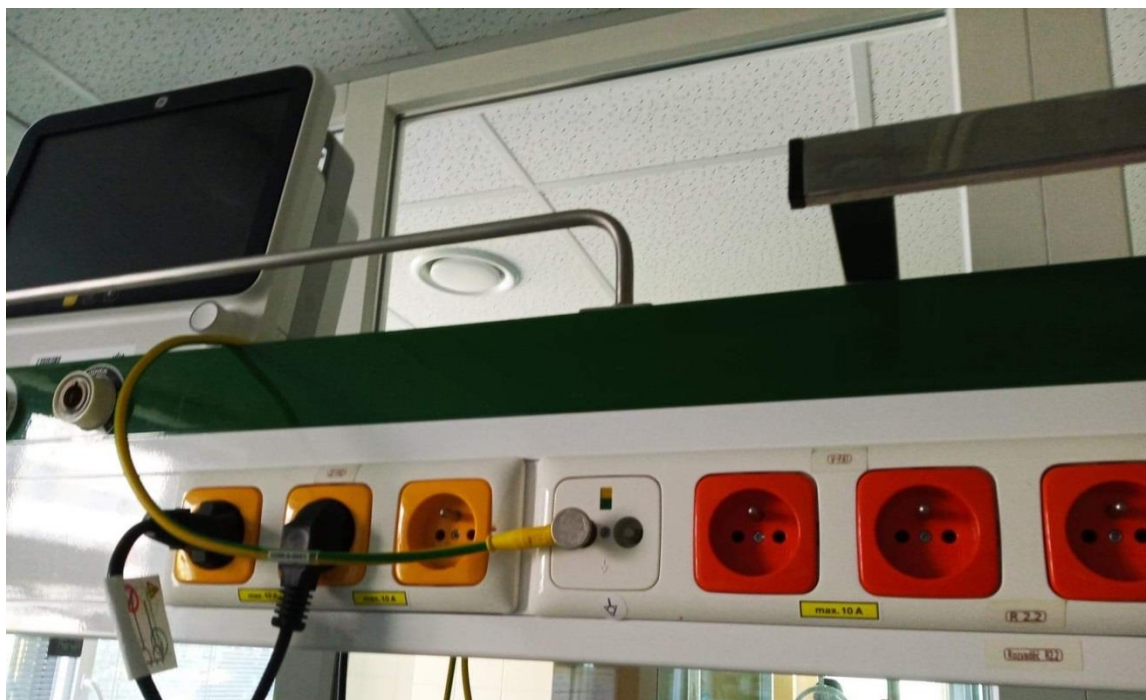
Obr. 22: Oranžové a žluté zásuvky dle ČSN 33 2140 (zdroj: autor)
