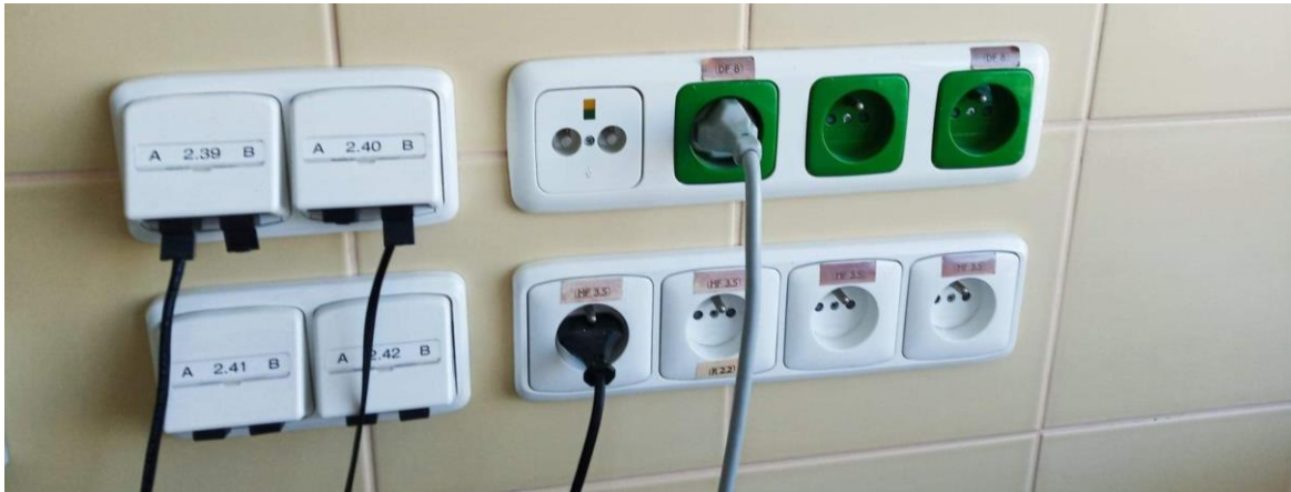
Obr. 23: Zelené zásuvky dle ČSN 33 2140 (zdroj: autor)
