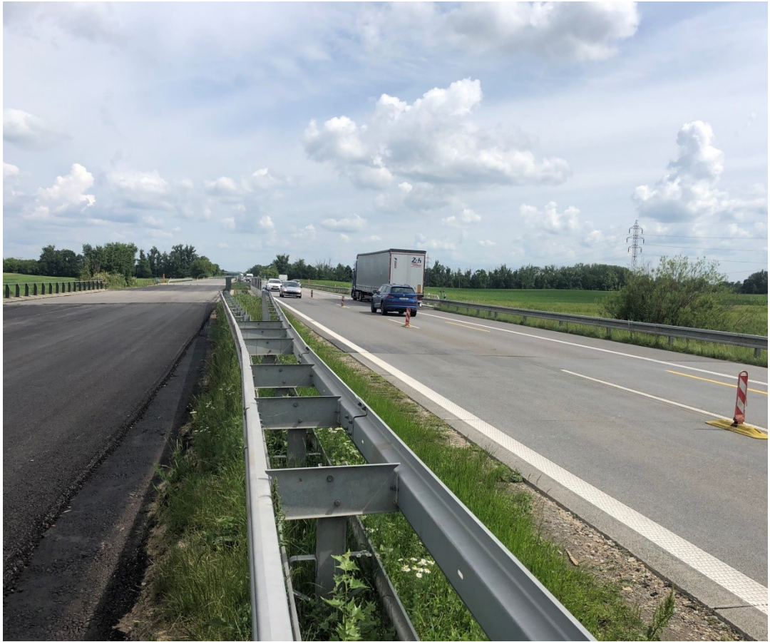
Obrázek 2 Dálnice D2 km 37 směr Bratislava [zdroj vlastní]
