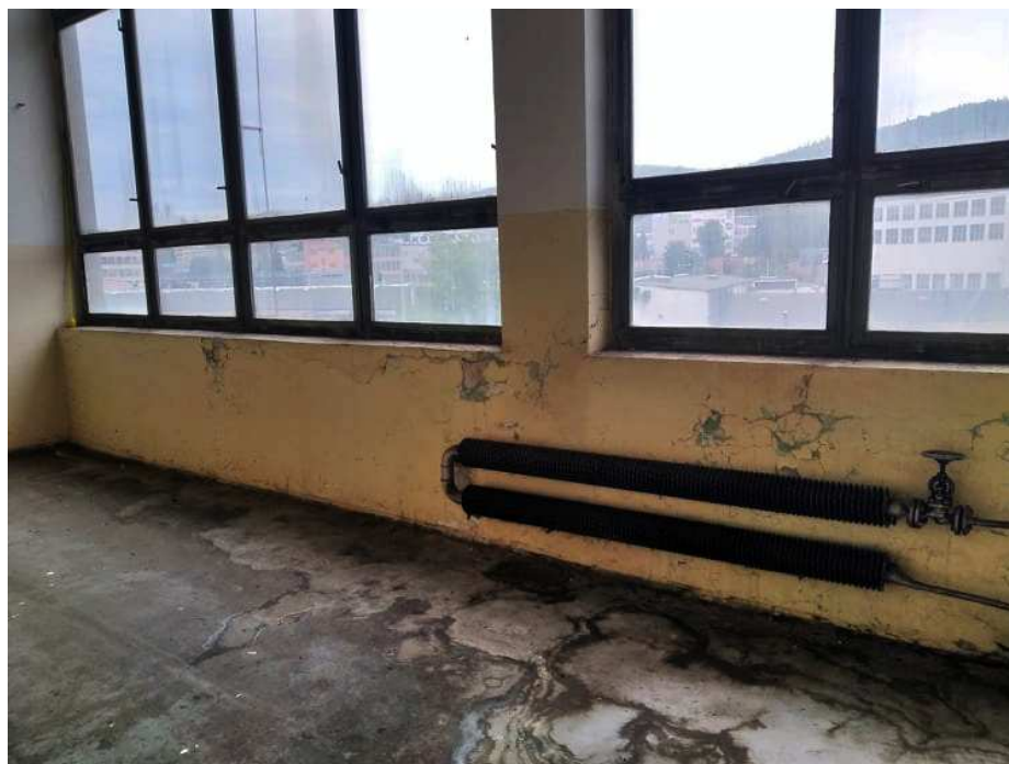
Obr. 34 Okna v místnosti
