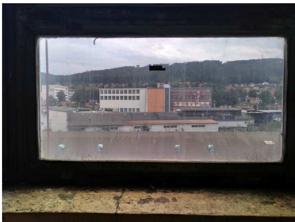
Obr. 33 Okno v místnosti
