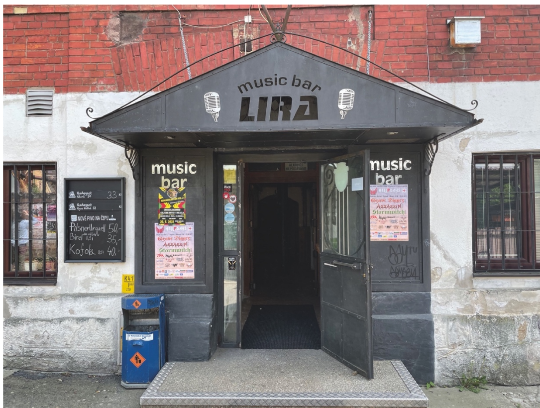
Obrázek 96: Původní stav exteriéru
