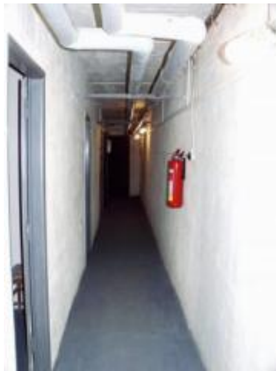
Obrázek 227 – Chodba se vstupy do místností stálého úkrytu. [Zdroj: Obr-227]
