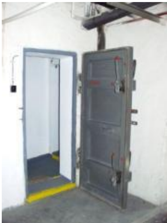
Obrázek 226 – Vstup do stálého úkrytu. [Zdroj: Obr-226]
