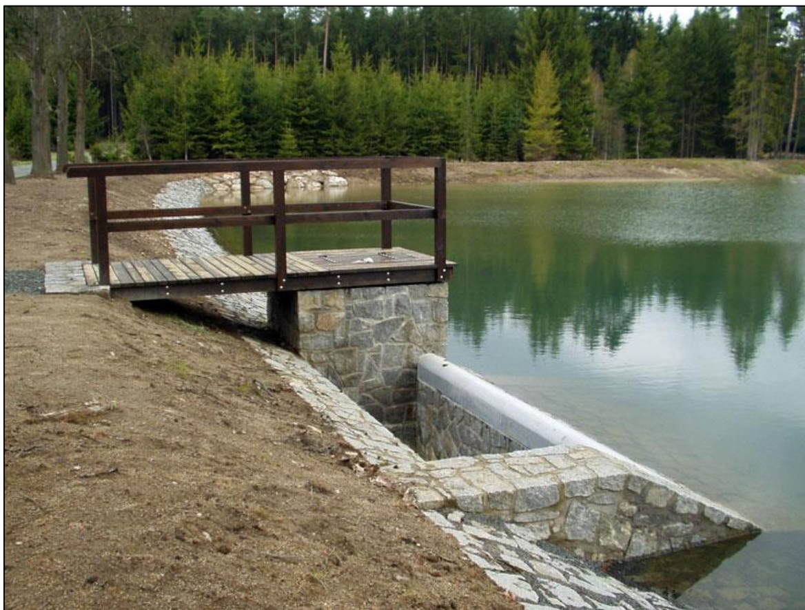
Obrázek 2 Retenční prostor v rybníku Suchý (Retenční nádrže na Lesní správě Žatec, Copyright © 2022)
