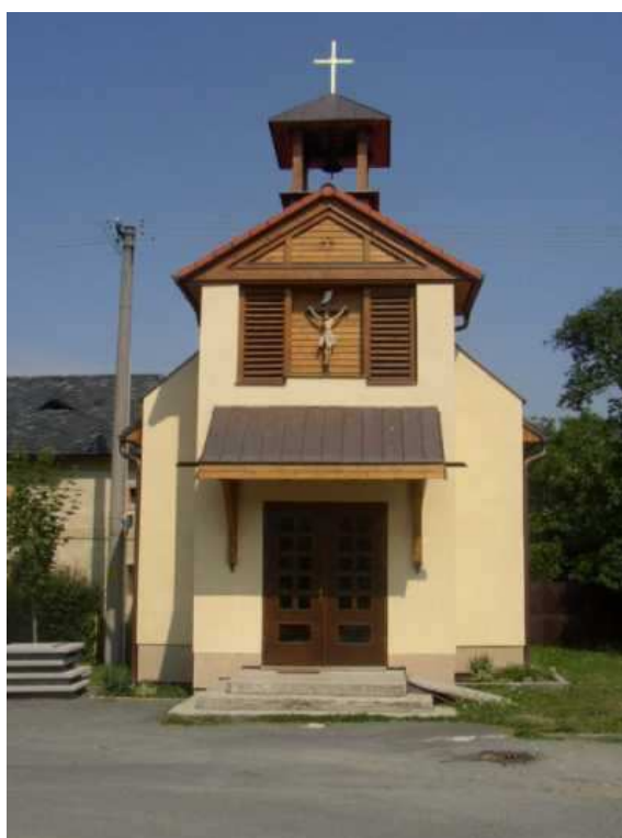
Rekonstruovaná kaple v obci Provodov.
