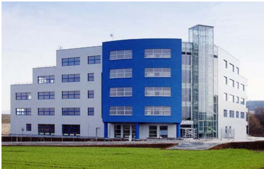
Obr. 13: Moderní budova výzkumného centra v Plzni 18
