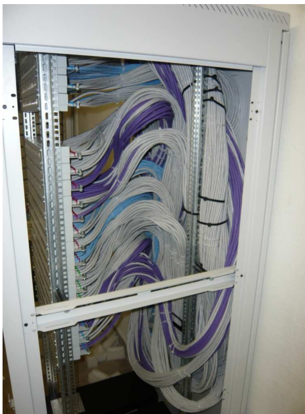
Obr. 19 Zapojenie všetkých 480 káblov do patch panelov
