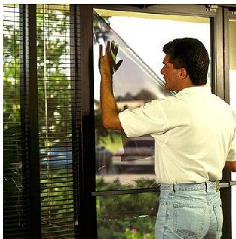
Obrázek 37: Aplikace folie a následky rozbití skla s folií
