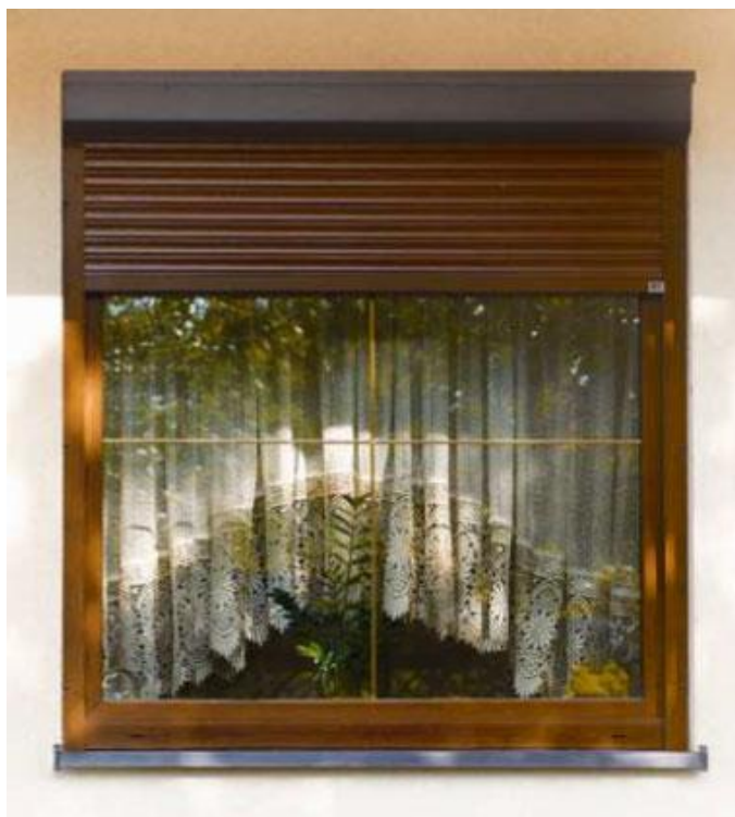
Obrázek 42: Okno v přízemí
