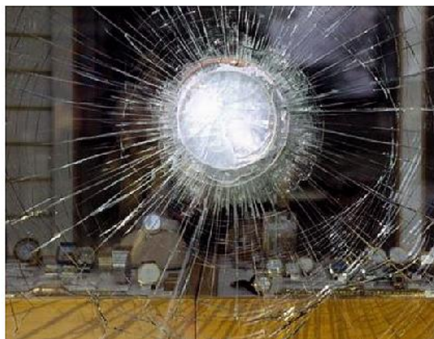
Obrázek 37: Aplikace folie a následky rozbití skla s folií
