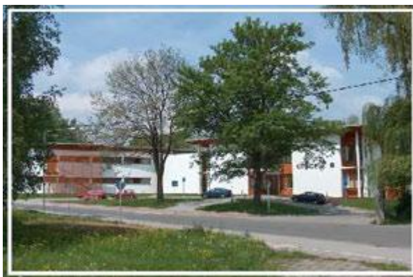
Obr. 3: Specializovaná hospicová paliativní péče poskytovaná v budově hospice
