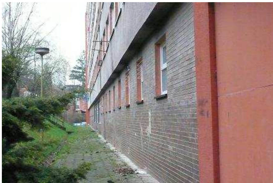
Obrázek č.8: Jižní strana domu
