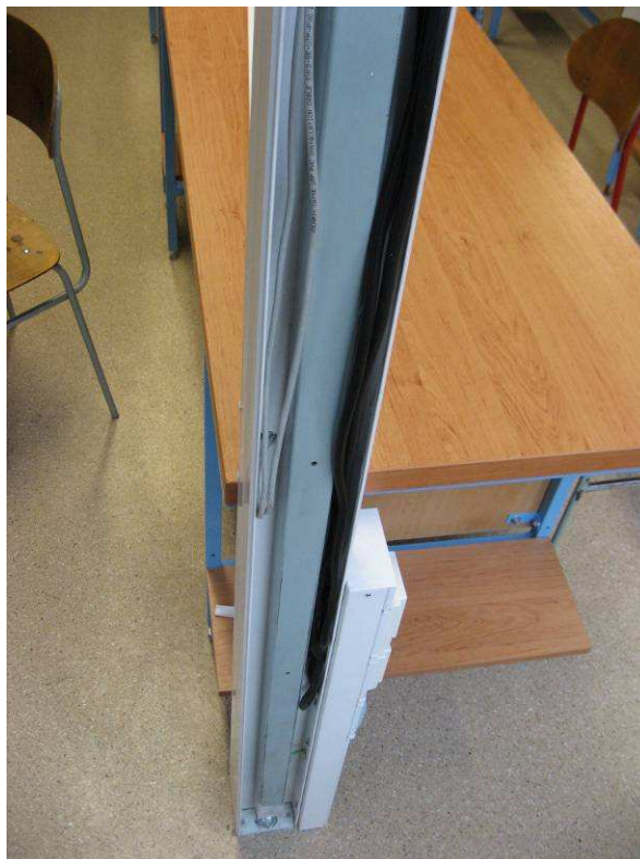
Obr. 24 Konstrukce elektroinstalačních sloupů
