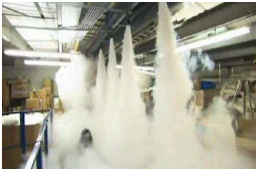
Obrázek 30 Vedení mlhy potrubím (5 sec.) [4]
