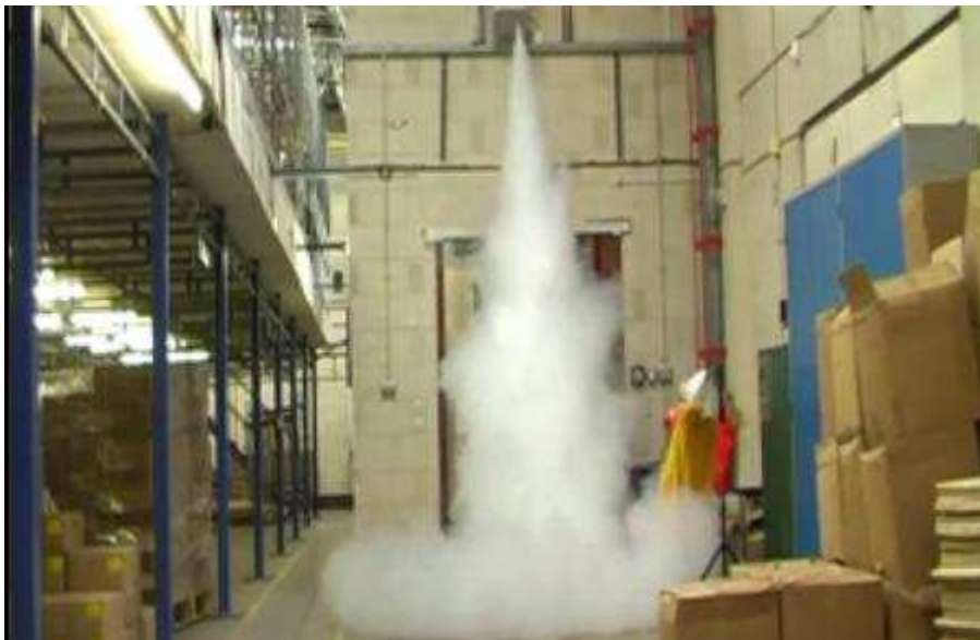
Obrázek 25 Distribuce mlhy přímo z generátoru [4]
