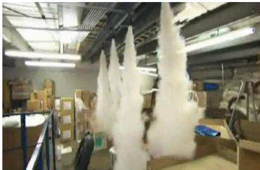
Obrázek 29 Vedení mlhy potrubím (2 sec.) [4]
