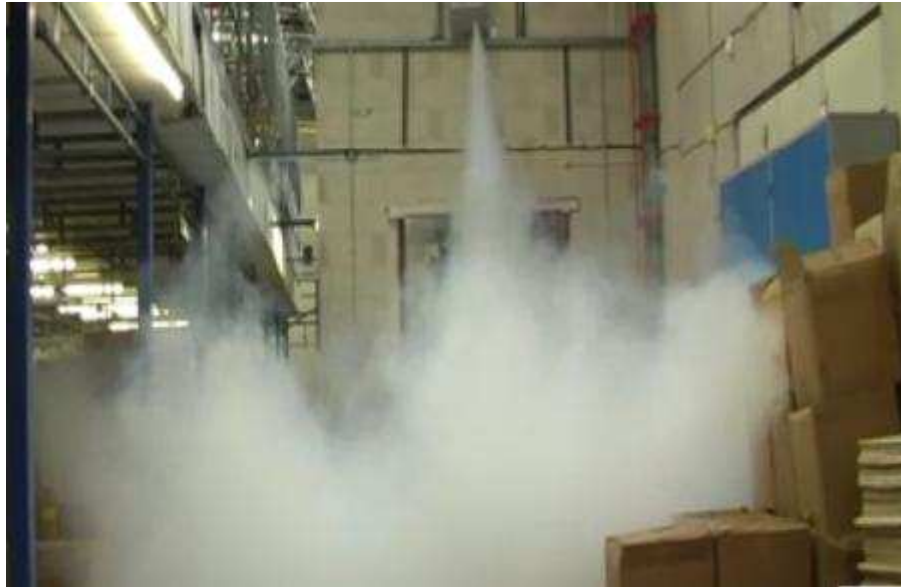
Obrázek 26 Distribuce mlhy přímo z generátoru [4]
