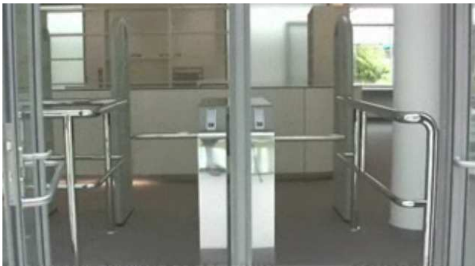
Obr. 7. Dvounohý tripodový turniket (vlastní foto-knihovna UTB)
