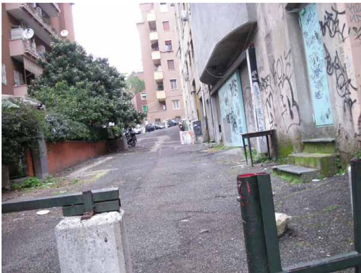
Obr. 13. Pohled na zadní vstup na jeviště
