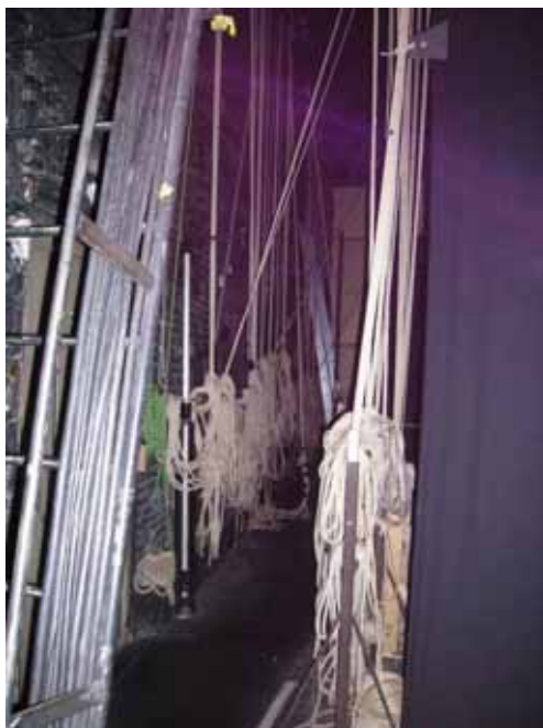
Obr. 12. Pohled do jevištní techniky
