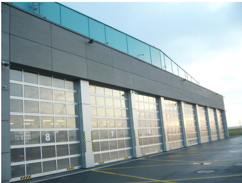
Obr. 1. Letiště Praha Ruzyně – budova výjezdů hasičského záchranného sboru.
