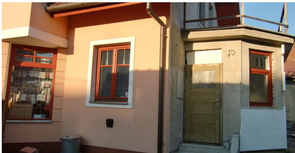
Obr. 14. Vstupní dveře do bytové části objektu
