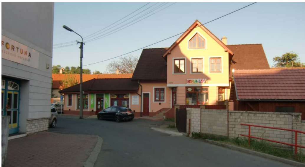
Obr. 11. Pohled na přední stranu objektu
