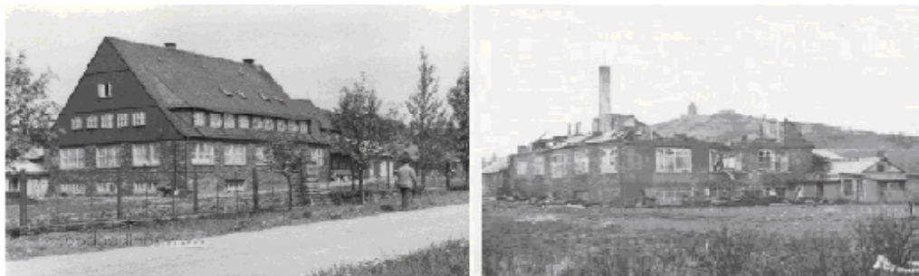
Obrázek 3 Před a po požáru [Zdroj: 18]
