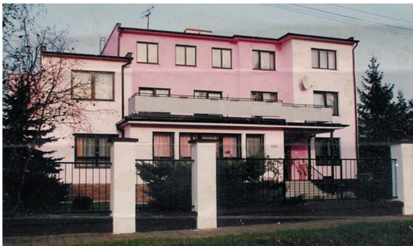
Obrázek 5 Domov před přestavbou [Zdroj: 10]
