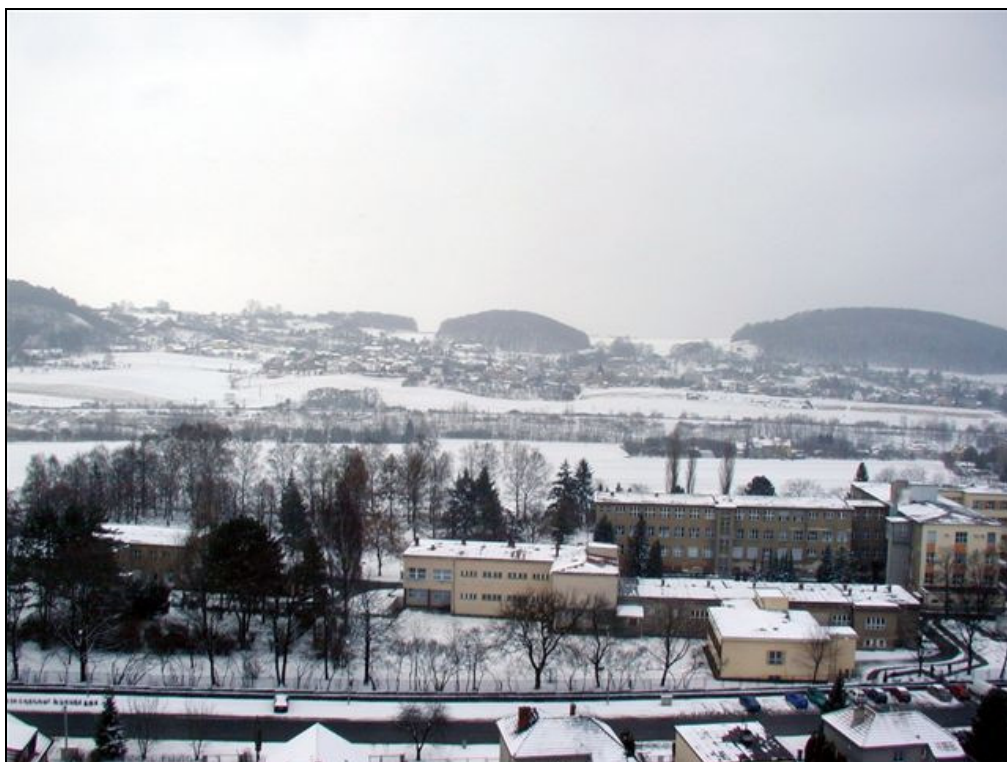
Obr. 13 Hranice – pohled směr východ
