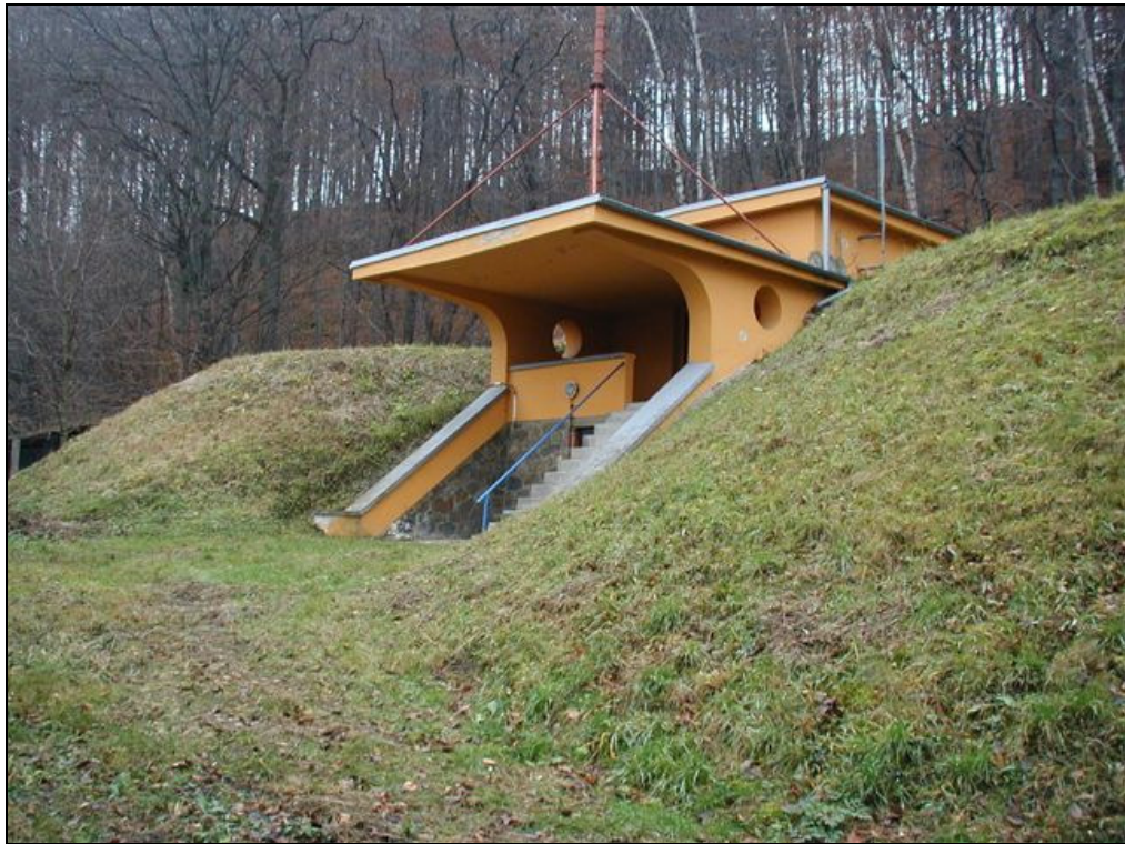
Obr. 15. Vodojem Bílý kámen
