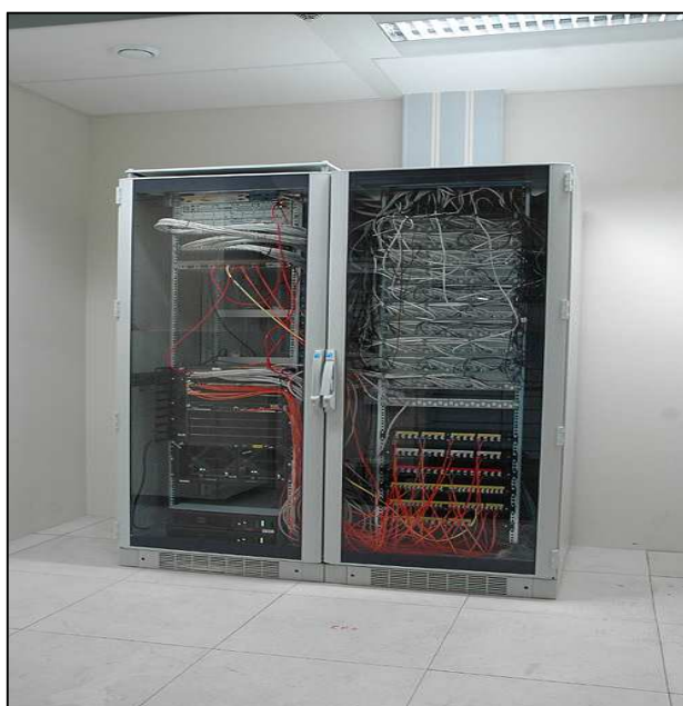
Obr. 7. Datový rozvaděč – rack.
