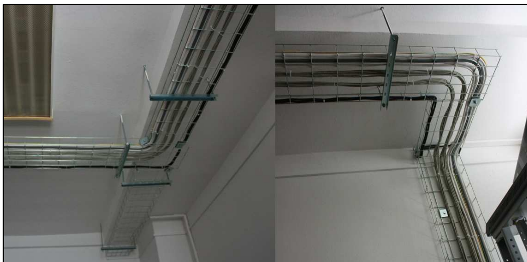
Obr. 20. Kabelové trasy tvořené drátěnými žlaby MERKUR.
