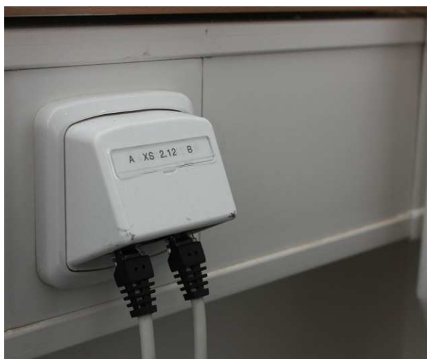
Obr. 21. Datová zásuvka v parapetním žlabu KOPOS PK 140 x 70 D.
