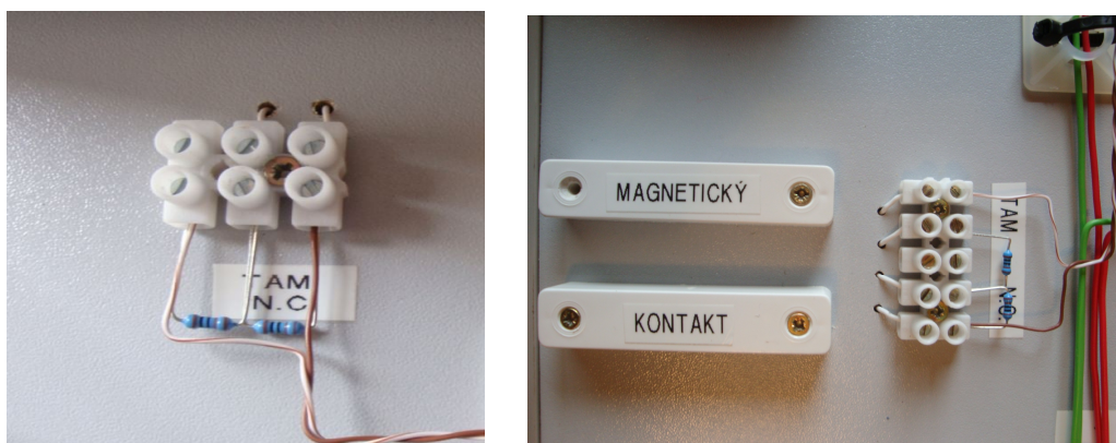
Obrázek 15: Správně zapojený TAMPRE PZS a MAGNETICKÝ KONTAKT
